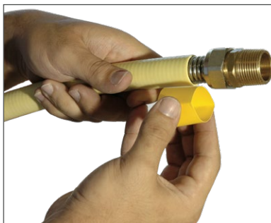
7. Prije spajanja prekrijte namotaje crijeva termo skupljajućom tubom da biste zaštitili crijevo od korozije.
