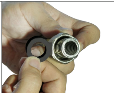
Postavite NBR brtvu i završite ženski spoj.
